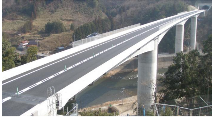
当社で施工した橋梁の例
