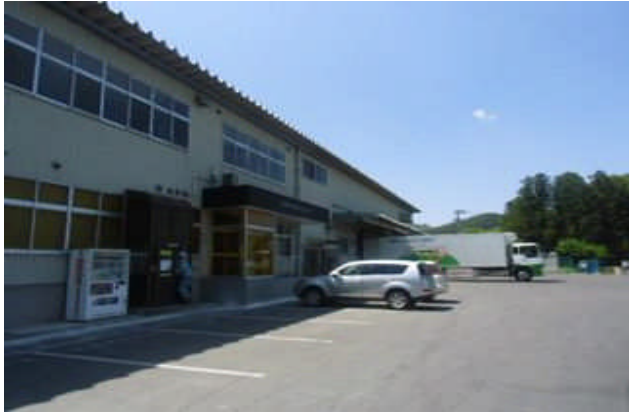
五戸工場外観
